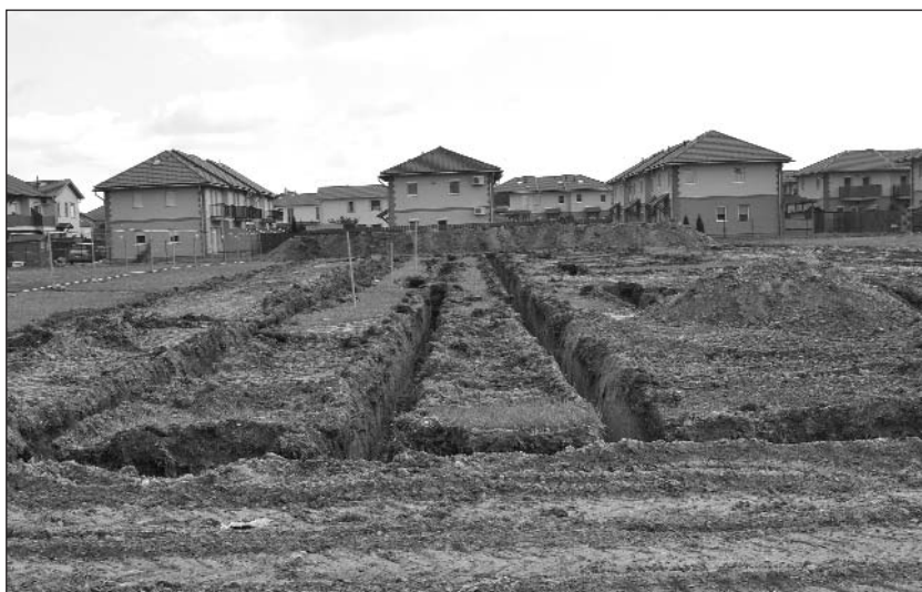
Elkezdődött az óvoda építése a Helikopter lakóparkban. A 75 gyermeknek helyet adó új intézménynek az alapkövét március 27-én rakták le, szeptembertől vehetik majd birtokba a gyerekek.
